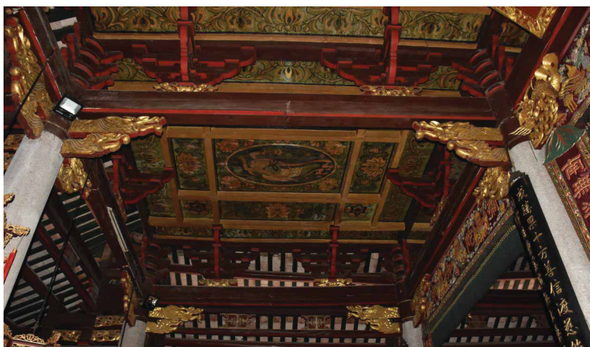
图 4-44 开元寺大殿斗栱
