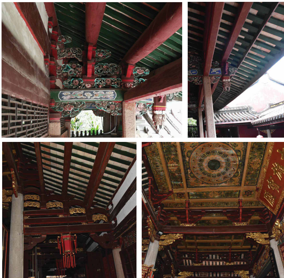
图 4-39 光孝寺大殿构架
