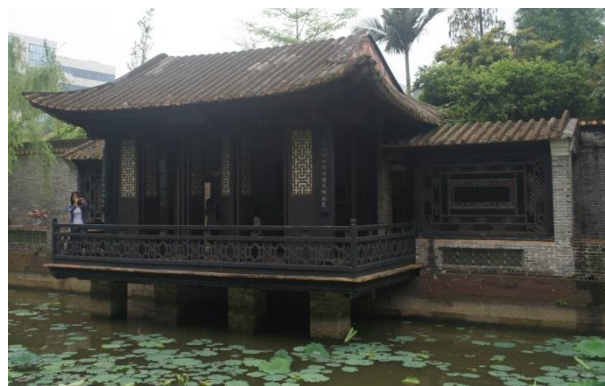
5.2-5 清晖园澄漪亭挑廊照片
