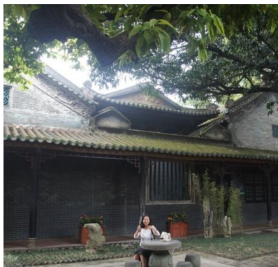
5.2-2 群星草堂对朝厅侧廊照片
