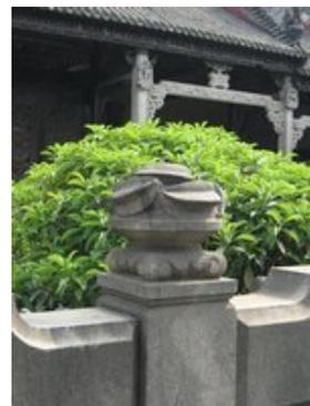
图 6.22 石刻杨桃望柱柱头
