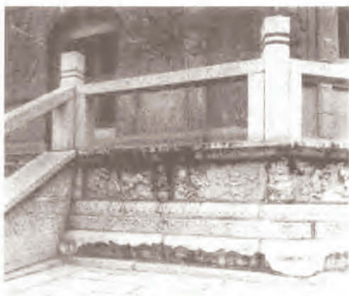
石作圖 38 階基 福建泉州開元寺石塔階基(宋)
