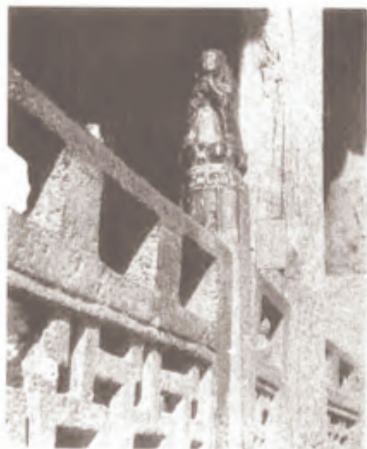
石作圖 50 鉤欄 河南濟源濟源廟臨水亭(龍亭)鉤欄(元)
