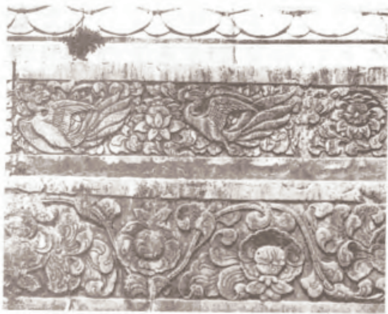
石作圖3 壓地顯起 南京棲霞寺舍利塔塔座彫刻(五代)
