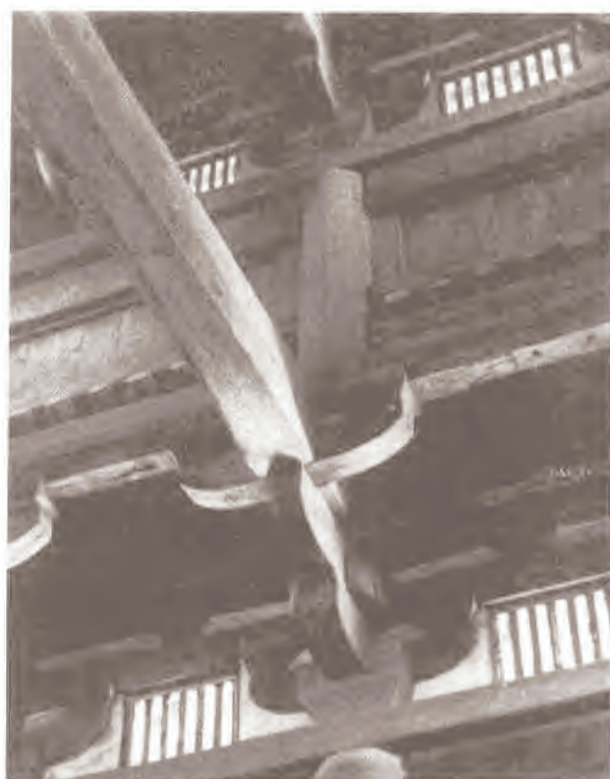
大木作圖 57 插柱造 河北正定隆興寺轉輪藏殿平坐內檐(宋)
