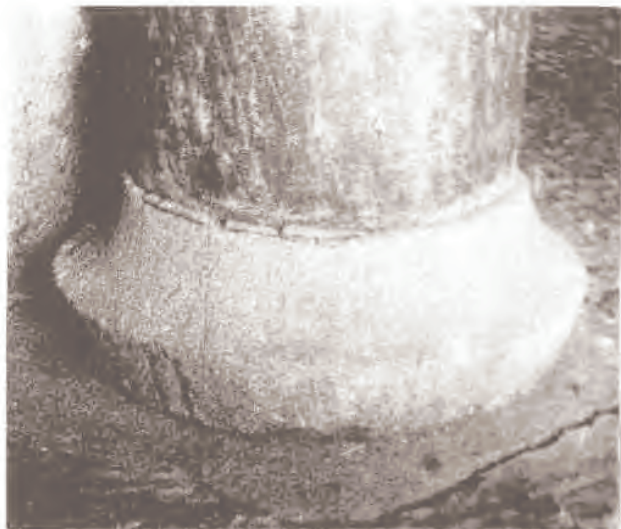
石作圖 30 攢形柱礎 浙江武義延福寺大殿柱礎(元)
