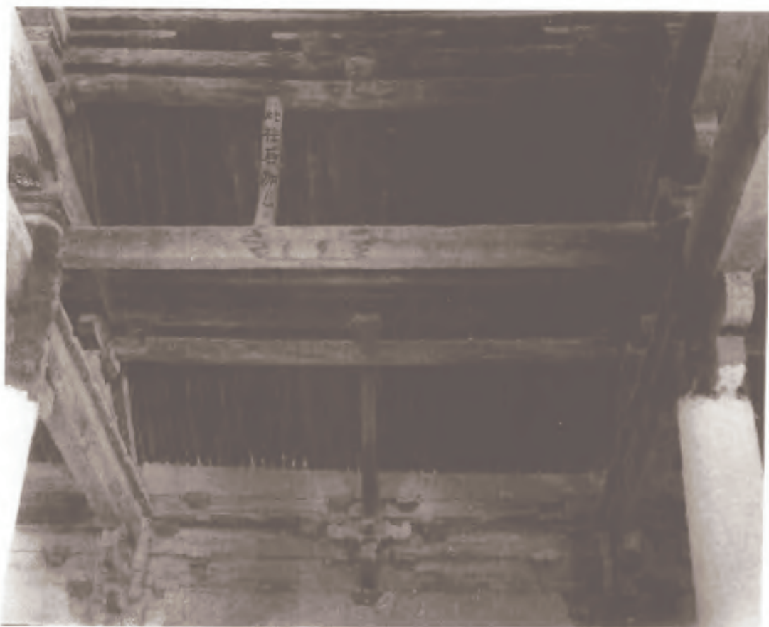
大木作圖 102 釋間 河北新城開善寺大雄寶殿(遼)
