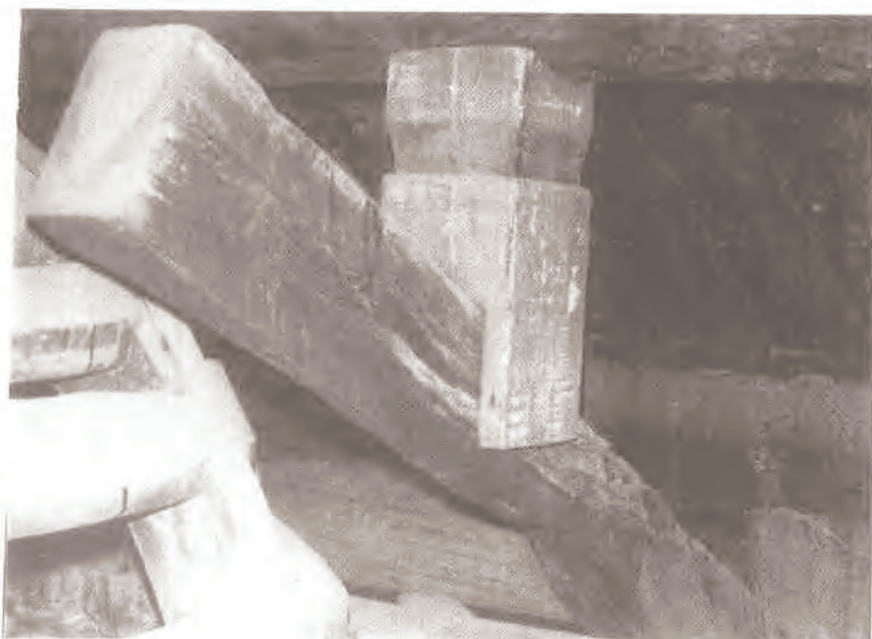
圖 35 “自轉安蜀柱以插昂尾”處理手法之一
