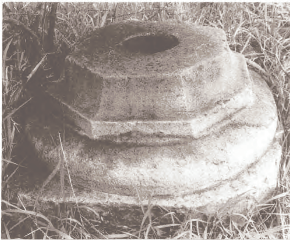
石作圖 28 素覆盆帶八角檁柱礎江蘇蘇州羅漢院大殿柱礎（宋）
