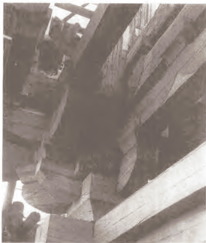
大木作圖 56 插柱造 河北正定隆興寺轉輪藏殿平坐外檐(宋)
