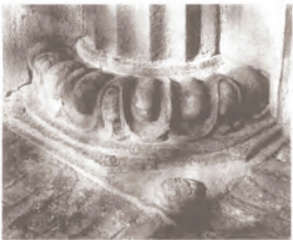
石作圖 34 蓮瓣柱礎 山東長清靈巖寺大殿柱礎(宋)
