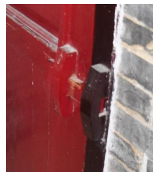
图 3-47 单扇门关闭时固定构件
