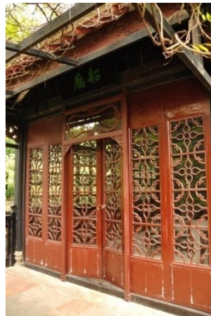
图 4-46 到脚屏门（清晖园船厅）
