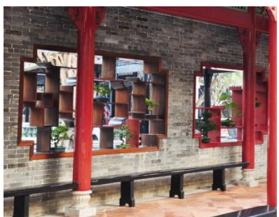
图 5-22 漏窗与廊柱的空间关系 设置不当
