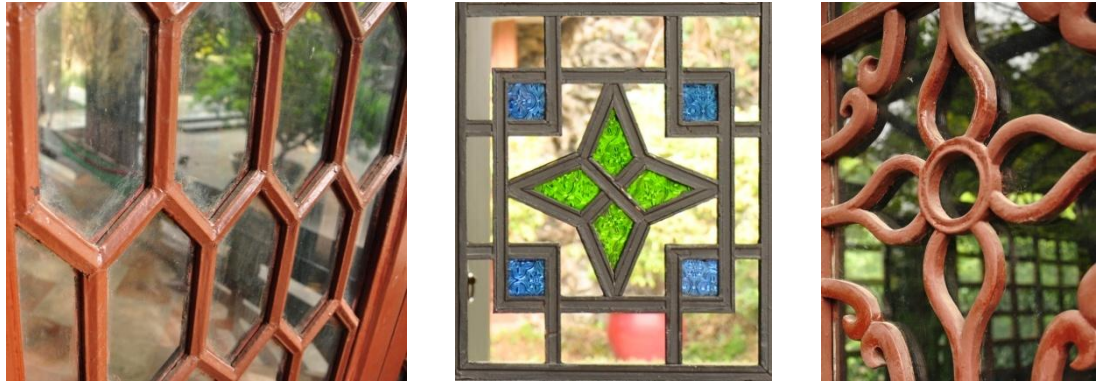
左：直子斗心（鸡胸断面）中：直子斗心（芝麻线断面）右：曲子斗心（仆竹形与昂竹形断面结合）
