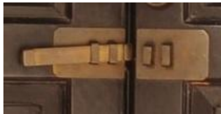
图 3-44 平开窗关闭时固定构件
