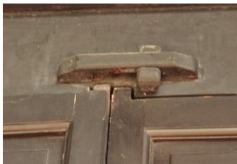
图 3-43 屏门关闭时固定构件
