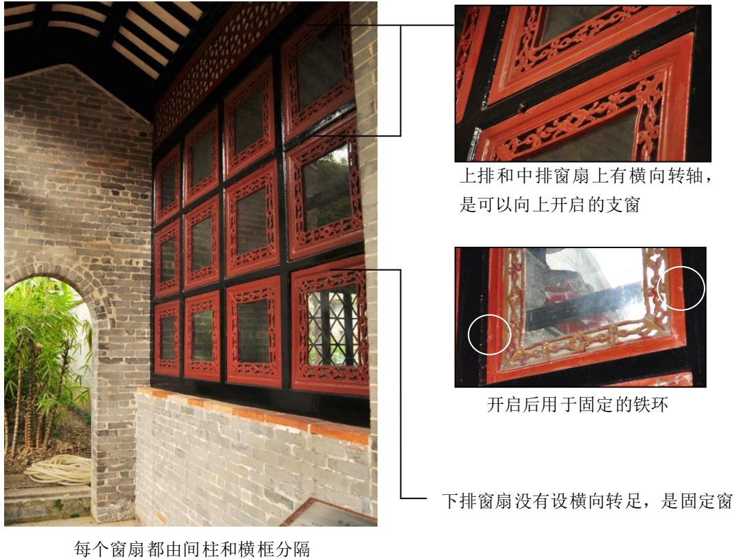
图 3-9 清晖园支摘窗构造示意图
