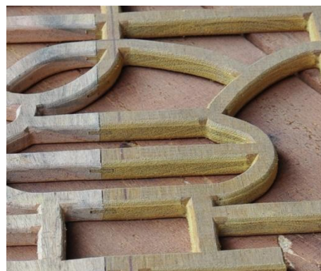
图 5-11 使用拉花机拉出的格心以及细部
