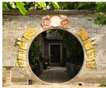
图 4-57 砖砌拱门洞，周边饰以灰塑对联
