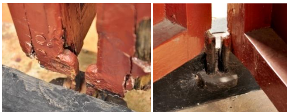
图 3- 38 传统屏门、平开窗用于开启的转轴及下连榫
