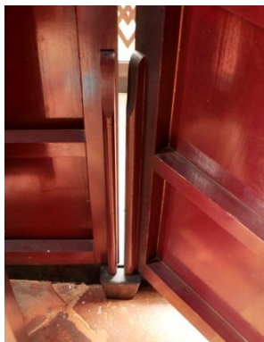
图 3- 35 传统屏门、平开窗用于开启的构件——木制转轴及下连榫
