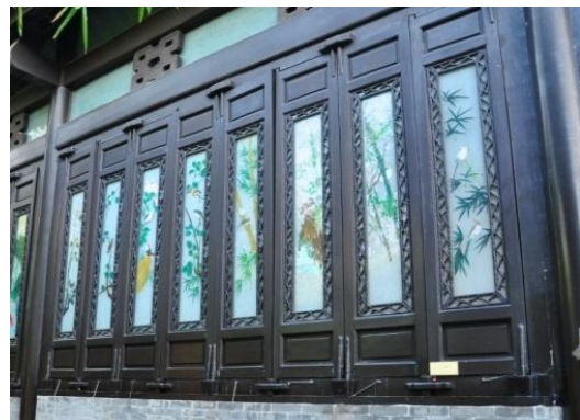
图 5-21 窗扇转轴的设置开在开间的中间
