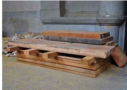
图 3-18 “重力压”方式防止格心变形
