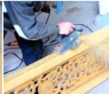
图 5-3 用电平刨对边挺表面刨平
