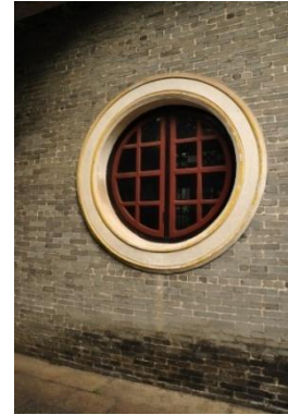
图 4- 30 窗洞内设窗扇 （梁园）
